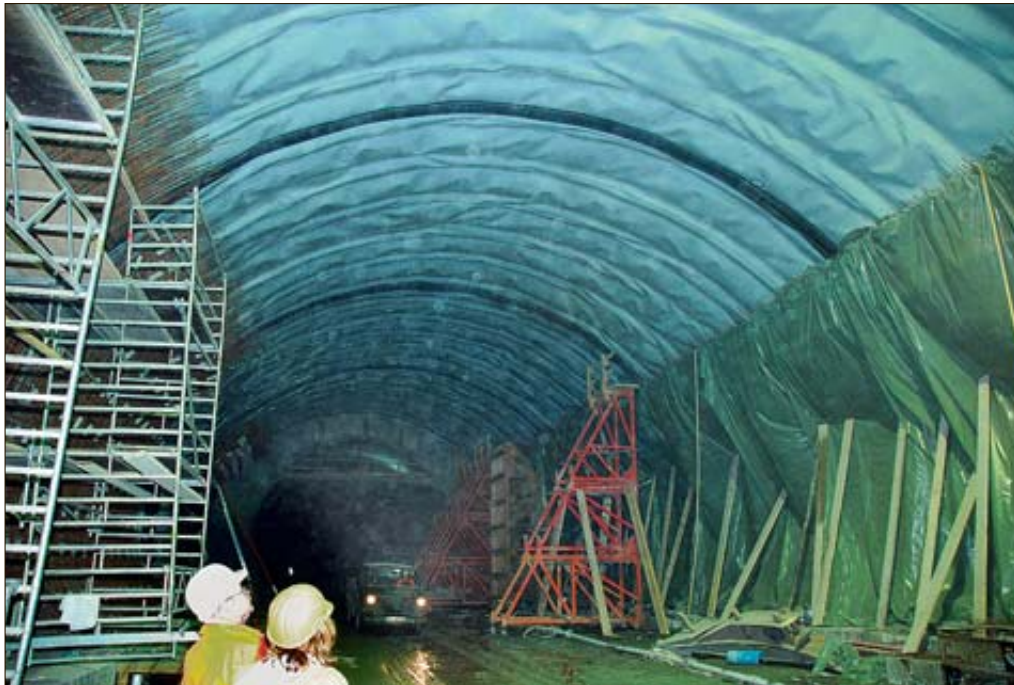
33.000 QUADRATMETER wasserdichte PE-Folie kleiden den Lohbertunnel und den dazugehörigen Fluchttunnel aus.
