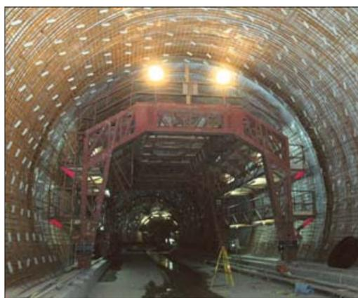
**DIE EISENFLECHTER schalen auf dem Bewehrungswagen die Röhre mit einem selbsttragenden Stahlgerüst aus. Dieses gibt dem 40 Zentimeter dicken Betonmantel, der durch den ...**
