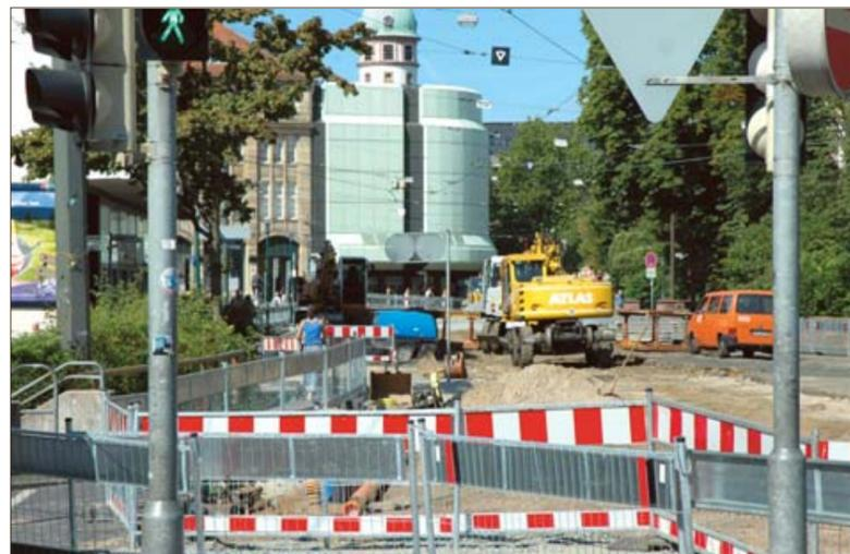
**SEIT DEM 5. JULI** geht kaum noch was in der Darmstädter Innenstadt. Grund hierfür ist die Verlegung der Bus- und Bahnhaltestelle am Ernst-Ludwig-Platz an die Südseite des Schlosses. Dafür müssen sämtliche Schienen entfernt und neu verlegt werden. Mit dieser Verlegung erhält Darmstadt an dieser Stelle erstmals nach 120 Jahren ein neues Gesicht. So lange bereits hatte die Haltestelle hier ihren angestammten Platz (Zum Bericht) (Bild: rh)
