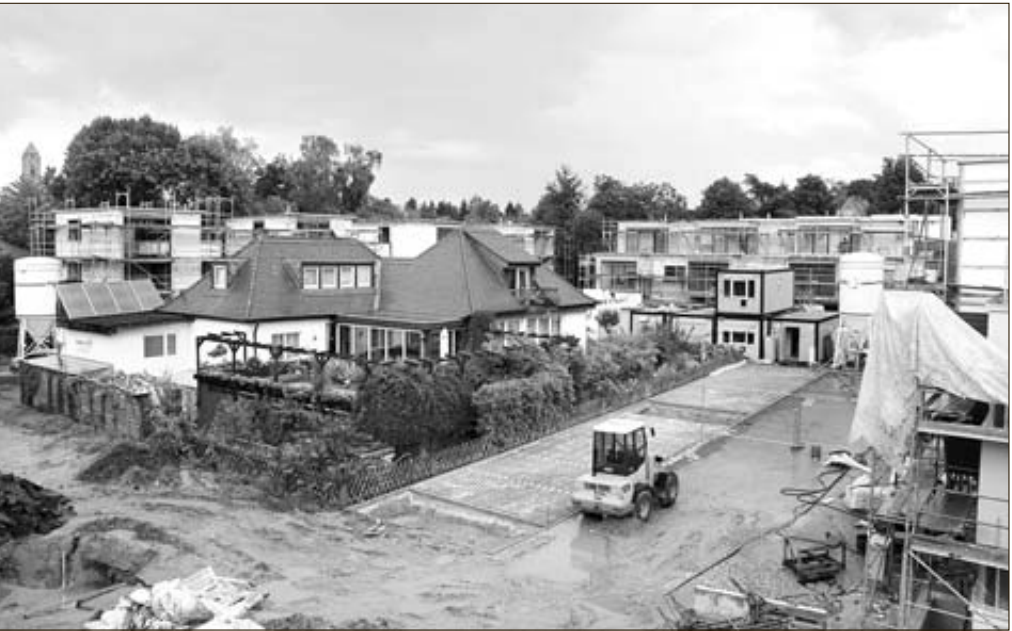
AUF VOLLEN TOUREN laufen die Bauarbeiten am Projekt „Alte Gärtnerei“ (unser rh-Bild); die Rohbauarbeiten fast aller Häuser sind abgeschlossen. Am 26. August konnten sich Kaufinteressenten und geladene Gäste einen Überblick über die Baufortschritte verschaffen und ein Musterhaus besichtigen, was von zahlreichen Besuchern wahrgenommen wurde.
