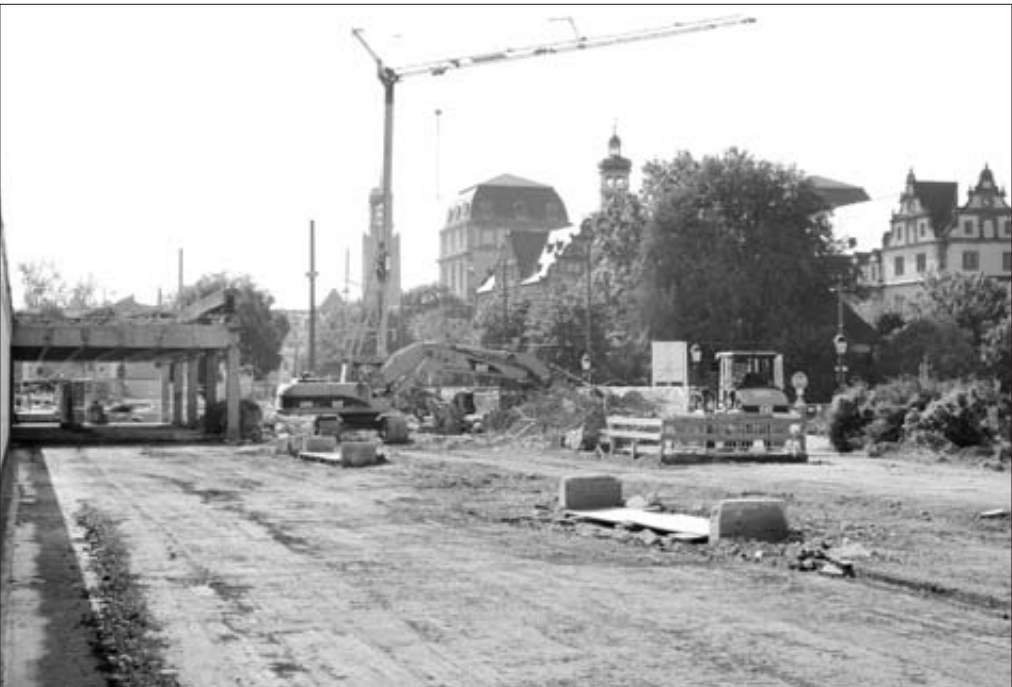
PLANIERT ist die Fläche zwischen Mollerbau und dem Audimax der TU Darmstadt, auf dem der Neubau des Kongreßhotels entstehen soll. Der Neugestaltung des Platzes fiel dieser Tage auch die, Ende der 60er Jahre gebaute, Betontreppe neben dem Universitätsgebäude zum Opfer – von den Hei-nern wenig liebevoll „Mussolini-Balustrade“ genannt. (Bild: rh)
