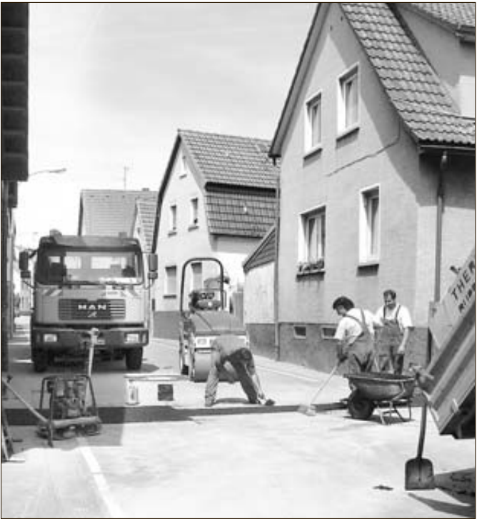
EINEN (FAST) AUTOFREIEN SAMSTAG konnten die Anwohner der Ober-Ramstädter Straße am 10.6. genießen. Wegen Bauarbeiten war die Strecke zwischen Dornwegshöhlstraße und Kili-anstraße für den Fahrzeugverkehr gesperrt. Ein Bautrupp arbeitete sich hier ab den frühen Morgenstunden vor, um Kanalschachtdeckel zu reparieren und eine Gaszuleitung zu verlegen. So sah man in der Straße viele sonst wegen des Verkehrslärms geschlossene Fenster weit offen und die Nachbarn nutzen die ungewohnte und willkommene Ruhe für den ein oder anderen Plausch auf der Straße. Weniger ruhig ging es hingegen in der Stift- und Steinstraße zu, über welche die Umleitung des Verkehrs an diesem Tag führten. Gegen Abend waren die Bauarbeiten beendet und der Verkehr konnte wieder ungehindert fließen.
