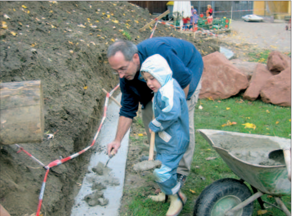
DIE BAUMMASSNAHMEN des neuen Sinnes- und Bewegungsgartens der ASB-Kindertagesstätte „Schlesierstraße“ in Eberstadt schreiten zügig voran. Aktuell baut Steinmetzmeister Harald Berg unter eifriger Beteiligung der Kinder eine Sandsteinmauer. Die Vogelnechtschaukel und das Trampolin wurden schon ihrer Bestimmung übergeben. Zur Fertigstellung fehlen noch einige Euro, Spenden sind daher sehr willkommen. Sie können auf das Konto 102034503 bei der Sparkasse Darmstadt eingezahlt werden, Stichwort „ASB-KiTa Schlesierstraße“. (Bild: hf)
