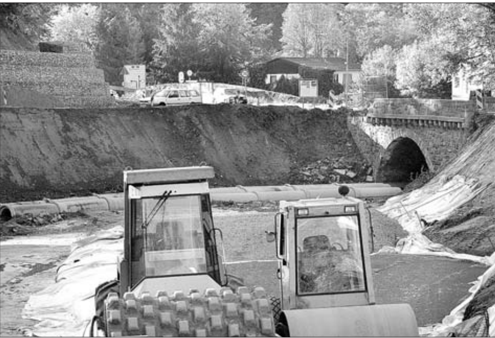
ES GEHT VORAN an der Felsnase. Die Bauarbeiten zur Straßenerneuerung und zum Brückenneubau an der B 426 laufen auf vollen Touren – bisher noch ohne die befürchteten Staus. Die Modau verschwindet im Bereich der Baustelle derzeit in Kanalrohren (unser rh-Bild); sie erhält nach deren Beendigung wieder „freien Lauf“. Laut dem Amt für Straßen- und Verkehrswesen Darmstadt liegt man mit den Arbeiten im Zeitplan. Eröffnet werden soll die Straße im Mai kommenden Jahres, gemeinsam mit dem Lohbertunnel.
