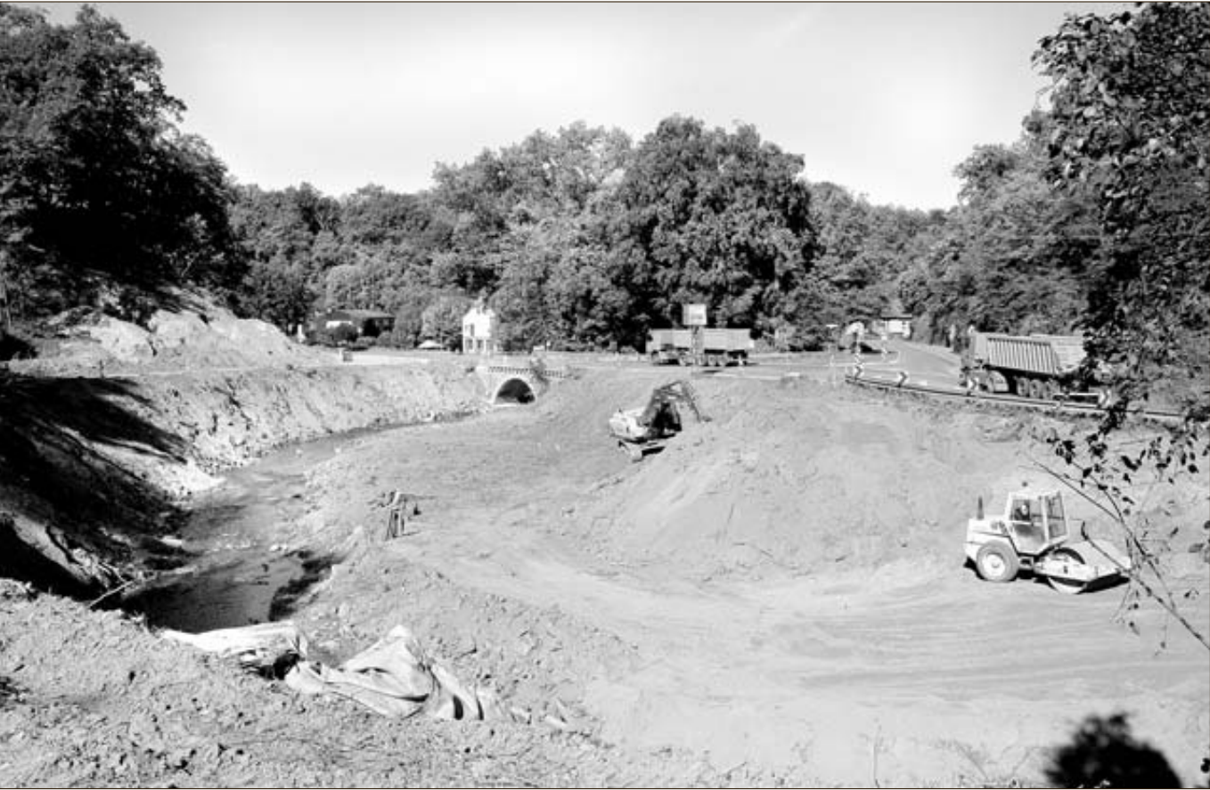
KAHLSCHLAG. Die B 426 in Höhe der Bohlenmühle gegenüber der „Felsnase“ verändert sich zusehends. Nachdem die Bäume und Büsche am Straßenrand und im Bachbett der Modau gerodet sind (siehe Bild in unserer letzten Ausgabe), sollen die Bauarbeiten nun zügig vorangehen. Wie bereits berichtet, werden zwei neue Brücken über die Modau gebaut. Die eine wird in begradigter Form an Eberstadt vorbeiführen. Die zweite Brücke ist an der Mühltalstraße für den Verkehr nach Eberstadt vorgesehen. Die Gesamtkosten der Straßenbaumaßnahmen sind auf 2,5 Millionen Euro taxiert, gab das Amt für Straßenverkehrswesen bekannt. Die Bauarbeiten sollen im Mai nächsten Jahres beendet sein – pünktlich zur Eröffnung des Lohbertunnels. (Bild: rh)
