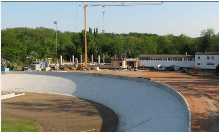
333 METER LANG, in einem 33 Grad-Winkel angelegt und somit für internationale Wettkämpfe hervorragend geeignet, entsteht derzeit an der Heidelberger Landstraße die neue Radrennbahn des Veloped Clubs Darmstadt (VCD). Die Rohbauarbeiten sind bereits abgeschlossen, die Bahn muß nur noch abgeschliffen werden. Am 11. August soll die Anlage für den Radsport freigegeben werden und am 25. August soll hier ein großes Radsportfestival stattfinden. (Zum Bericht) (Bild: mow)
