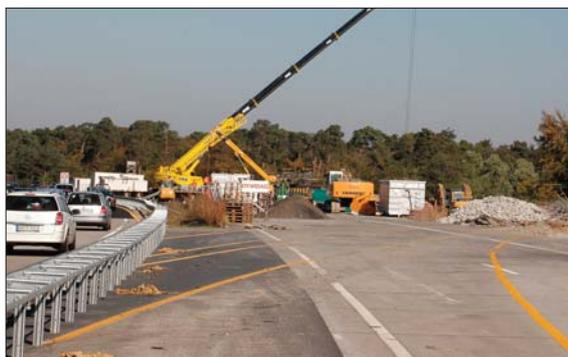
WIEDER IN GEWOHNTE BAHNEN verläuft der Verkehr auf der A5 zwischen Darmstadt und Eberstadt. Dort mußte wegen schlechtem Zustand des Bauwerkes die Brücke über die Bahnstrecke Heidelberg – Frankfurt erneuert werden. Die Behelfsbrücke wurde in der vergangenen Woche abgebaut, die Sanierungsarbeiten sind voraussichtlich im Frühjahr 2008 abgeschlossen. (Bild: th)
