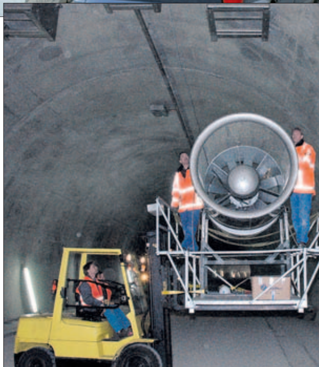
DREI riesige Ventilatoren werden an der Tunneldecke befestigt.
