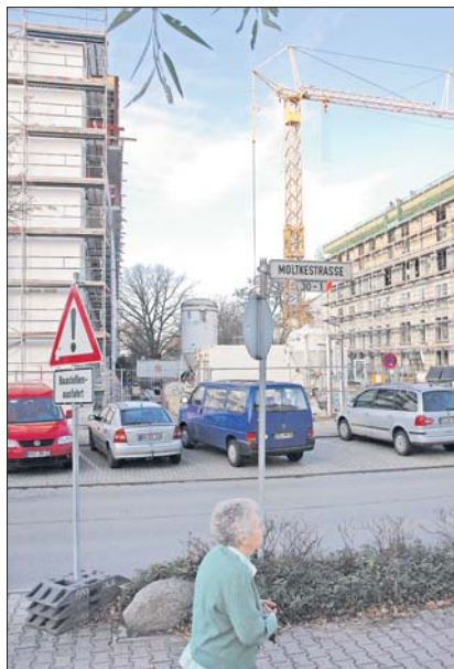
SANIERT UND MODERNISIERT werden die Wohnhäuser der bauverein AG Darmstadt in der Moltkestraße. Am 19.11. konnte Richtfest gefeiert werden. (Zum Bericht) (Bild: Ralf Hellriegel)
