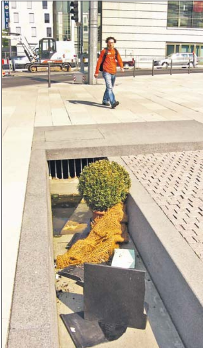
RINNE ODER NICHT RINNE – das ist hier die Frage. Etwa 500 Meter lang ist das Anschlussstück, das die bereits vorhandene – und leider als Abfalleimer missbrauchte – Rinne vor dem Darmstadter Hof mit dem Herrngartenteich verbinden und dort für Regenwasserzufuhr sorgen soll. Oder auch nicht... (Zum Bericht) (Bild: Sandra Berlieb)
