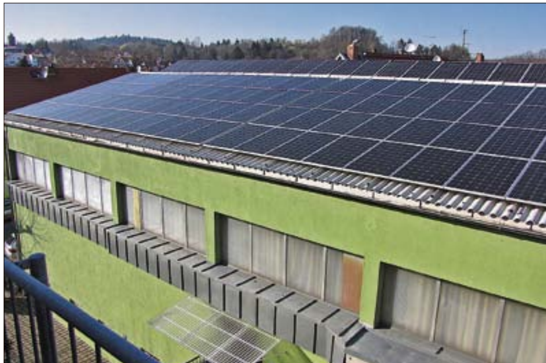
RUNDUM ERNEUERT präsentiert sich die Sporthalle des TSV Nieder-Ramstadt seit einigen Wochen. Die Fassade erhielt einen neuen Anstrich und auf dem frisch sanierten Dach wurde eine Photovoltaik-Anlage installiert. (Zum Bericht) (Bild: Agentur Achenbach)
