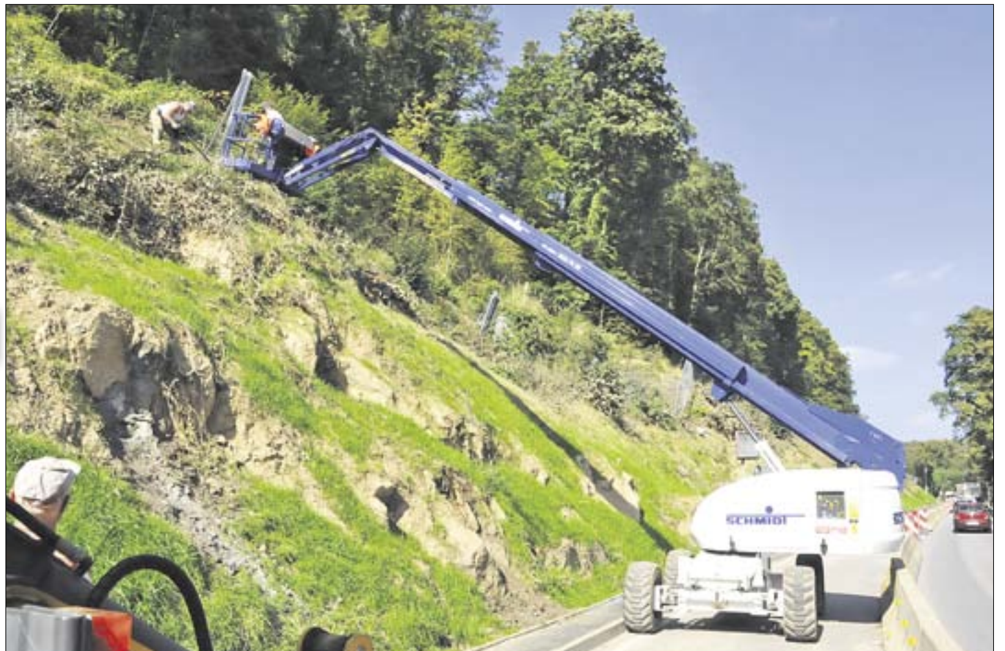
ZUR ABSICHERUNG des Schleifberges an der Felsnase sind Arbeiter derzeit damit beschäftigt, über mehrere hundert Meter Pfosten in die Erde zu setzen und Zäune zu spannen. (Bild: Ralf Hellriegel)
