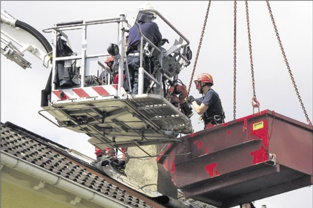
HÖHENRETTET der Berufsfeuerwehr Darmstadt waren in der Klappacher Straße in Bessungen mit dem Abtragen eines maroden Schornsteins beschäftigt, der durch das Erdbeben einzustürzen drohte. (Zum Bericht)
