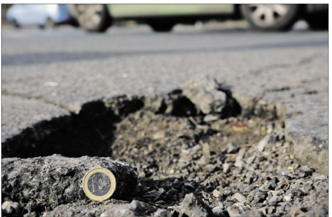
EURO-TIEFE ASPHALT-KRATER in den Straßen: Schlaglöcher sollen im Frühjahr verschwinden, fordert die IG BAU. Jeder Euro, der für intakte Fahrbahndecken investiert werde, sei gut angelegt. „Denn Schlaglöcher sind für die Federung von Autos eine Herausforderung – und für Radfahrer sogar eine kleine Katastrophe“, so die IG BAU. (Zum Bericht) (Bild: IG Bau)
