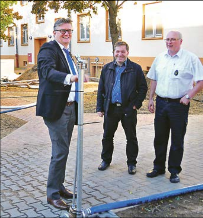
PROVISORISCHE WASSERINSTALLATION in den Kelley-Barracks, inspiziert von Bürgermeister Rafael Reißer, dem städtischen Flüchtlingsbeauftragten Jörg Rupp und Johann Braxenthaler, Chef der Darmstädter Berufsfeuerwehr. Nach Beendigung der Arbeiten an zwei Wohnblocks wird auch dieses Provisorium der Vergangenheit angehören.
