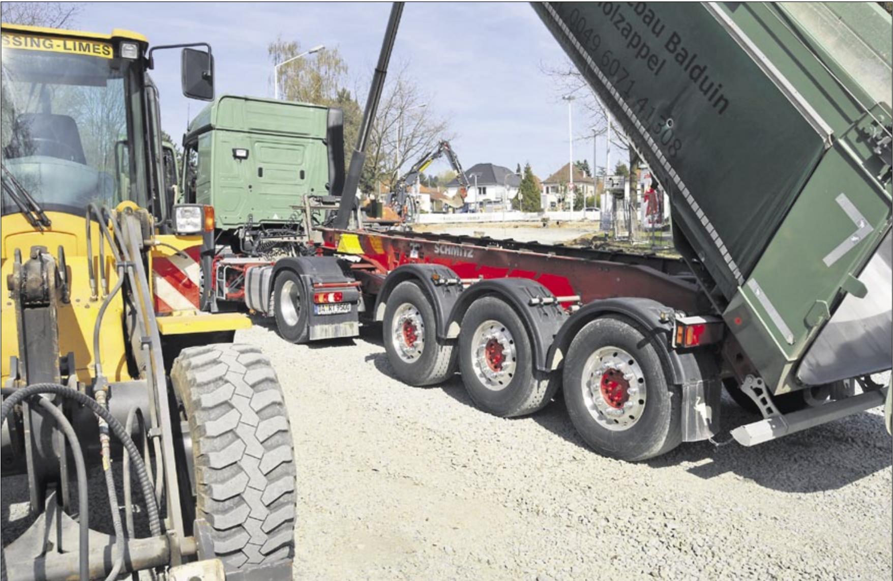
MIT ÜBER EINEM JAHR VERZÖGERUNG hat jetzt das umstrittene Bauvorhaben eines Verkehrskreisels am Ortseingang von Eberstadt begonnen. Wie unser Bild zeigt, ist die Straßendecke bereits weitgehend abgetragen worden. Geplant ist die Neugestaltung des betreffenden Abschnittes der Reuterallee und der Heidelberger Landstraße bis hinter die Einmündung der Katharinenstraße bzw. der Ostpreußenstraße. Nach Planung des Stadtbauamtes sollen die reinen Bauarbeiten am Kreisel noch im August diesen Jahres abgeschlossen werden. (Bild: Ralf Hellriegel)
