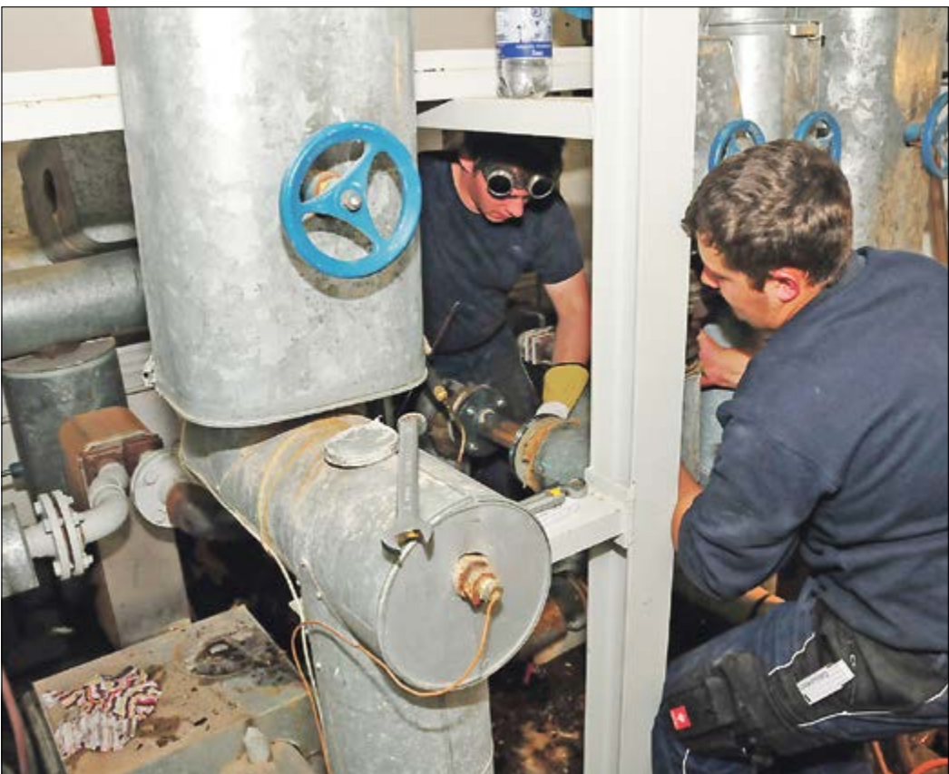
WIEDERHERSTELLUNG der Heizungsanlagen in den Kasernenblocks – wie hier in der Jefferson-Siedlung – ist eine der wichtigsten Arbeiten dieser Tage. Die kalte Jahreszeit naht.
