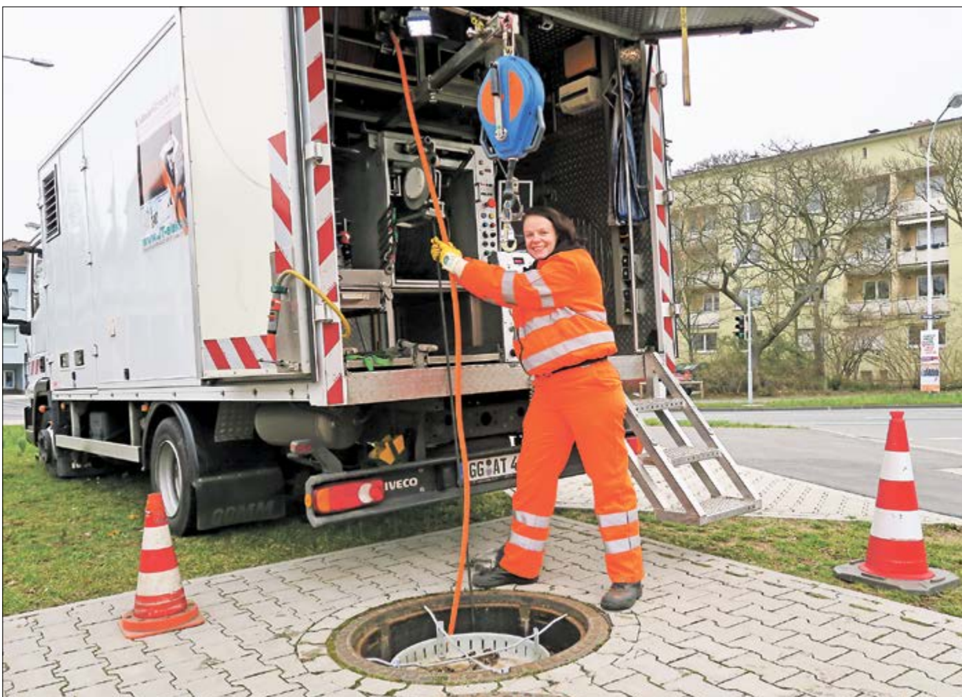
NOCH BIS 15. APRIL werden zwischen 9 Uhr und 15 Uhr in der Rüdesheimer Straße und im Haardtring im Bereich des Danziger Platzes Kanaluntersuchungen durchgeführt, wie auf unserem Bild mit Kanalinspekteurin Anja Bauer. Aufgrund der Untersuchungen wird in diesem Abschnitt die Fahrbahn verengt und es kann zu Verkehrsbehinderungen kommen.
