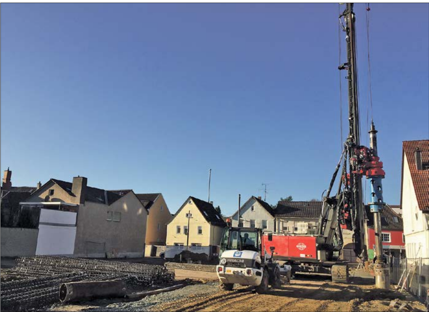
AUFWÄNDIGE BOHRUNGEN im Ortskern (Zum Bericht) (Bild: City Wohnen Eberstadt)
