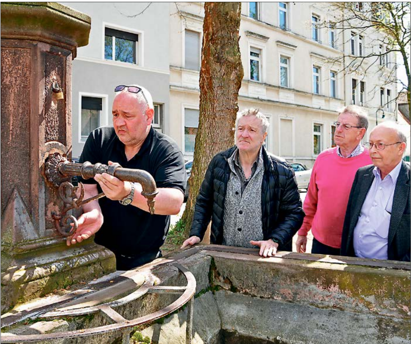
SO KÖNNTE SIE BALD WIEDER AUSSEHEN, die Brunnebitt nebst ihrem gusseisernen Auslauf. Brunnenspezialist Bernhard Rolig hat das vor zwei Jahren mutwillig abgetretene Stück schon mal provisorisch angehalten. Beim Ortstermin am vergangenen Dienstag (12.) waren ebenfalls anwesend (v.r.) Dipl.-Ing. Wolfgang Krämer von der Stadt Darmstadt sowie Charly Landzettl und Horst Uhrhan vom Vorstand der Bürgeraktion Bessungen-Ludwigshöhe. (Zum Bericht) (Bild: Ralf Hellriegel)
