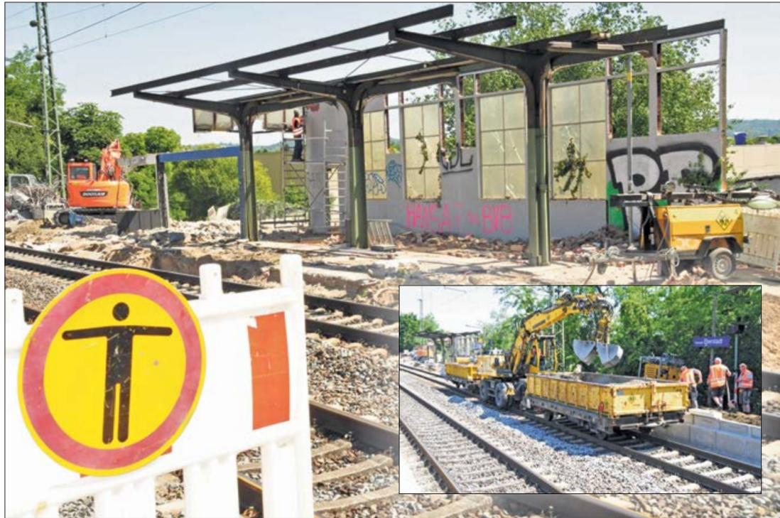
**DIE LETZTEN ABRBRUCHARBEITEN** am Empfangsgebäude des Eberstädter Bahnhofs sind – nach kurzzeitigem Abriss-Stop wegen Asbestfundes – beendet. Unser Bild entstand Mitte letzter Woche, als das Stahlkorsett abgetragen wurde und Gleisbauarbeiter gleichzeitig mit der Höherlegung des Gleises 1 beschäftigt waren (kleines Bild). (Bilder: Ralf Hellriegel)
