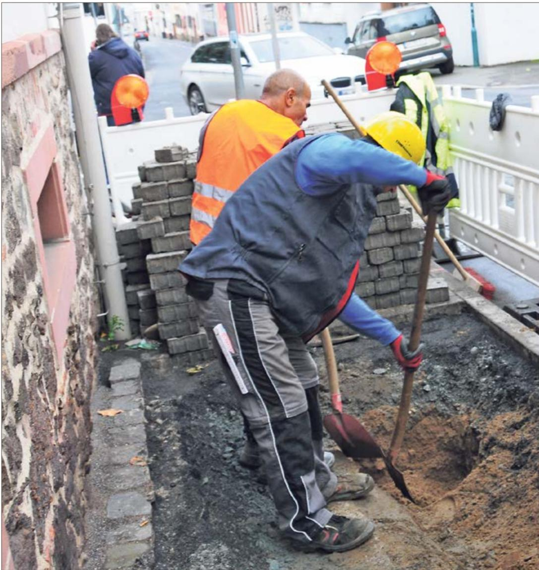
**NEUE STROMKABEL.** Die e-netz Südhesen erneuert derzeit in der Bessunger Straße Höhe Hausnummer 66 bis 84 und in der Forstmeisterstraße Höhe Hausnummer 2 bis 16 Niederspannungs- und Beleuchtungskabel. Darüber hinaus werden Leerrohre für die Telekommunikation verlegt. In der Forstmeisterstraße wird zudem der Wasseranschluss des Brunnens
