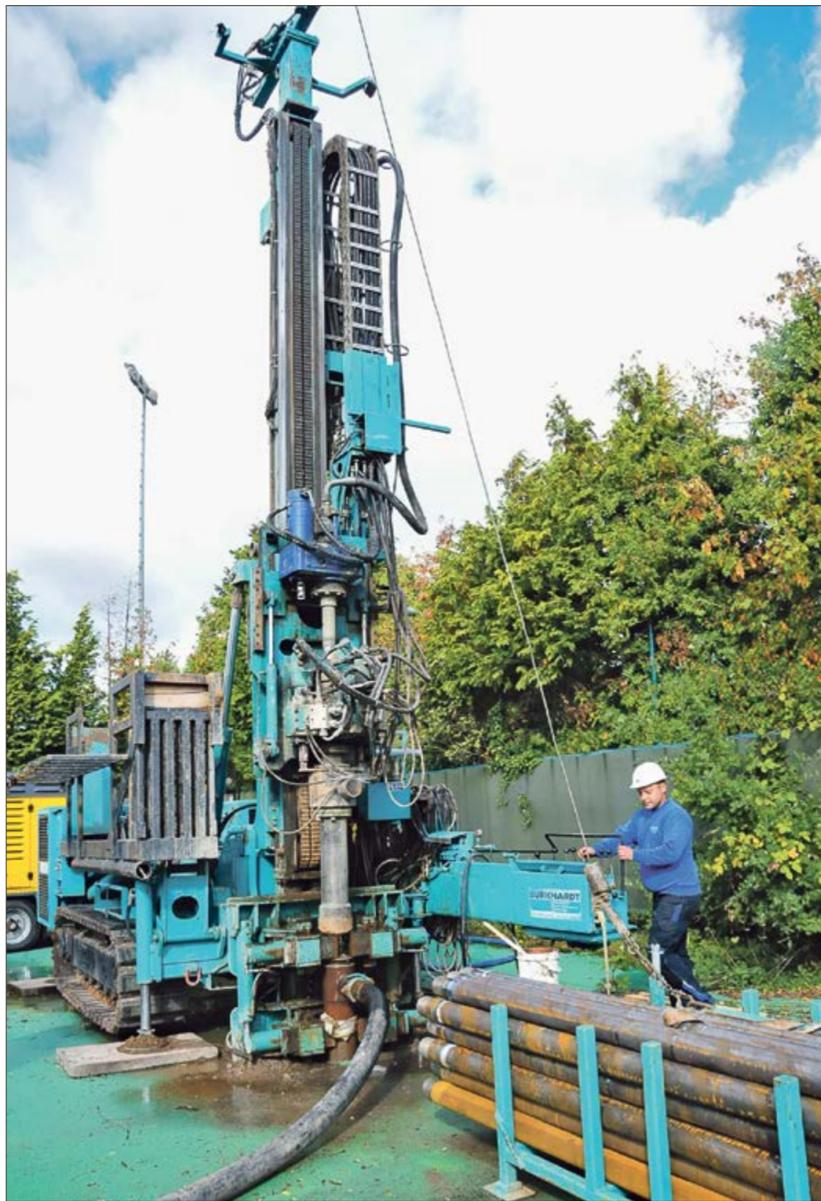
EINE ERDWÄRMESONDE wurde am 30. September in der Cambrai-Fritsch-Kaserne in 250 Meter Tiefe eingebracht, um festzustellen, inwieweit im Ludwigshöhviertel zukünftig weitestgehend emissionsfreie Wärme gewonnen werden kann. (Zum Bericht)
