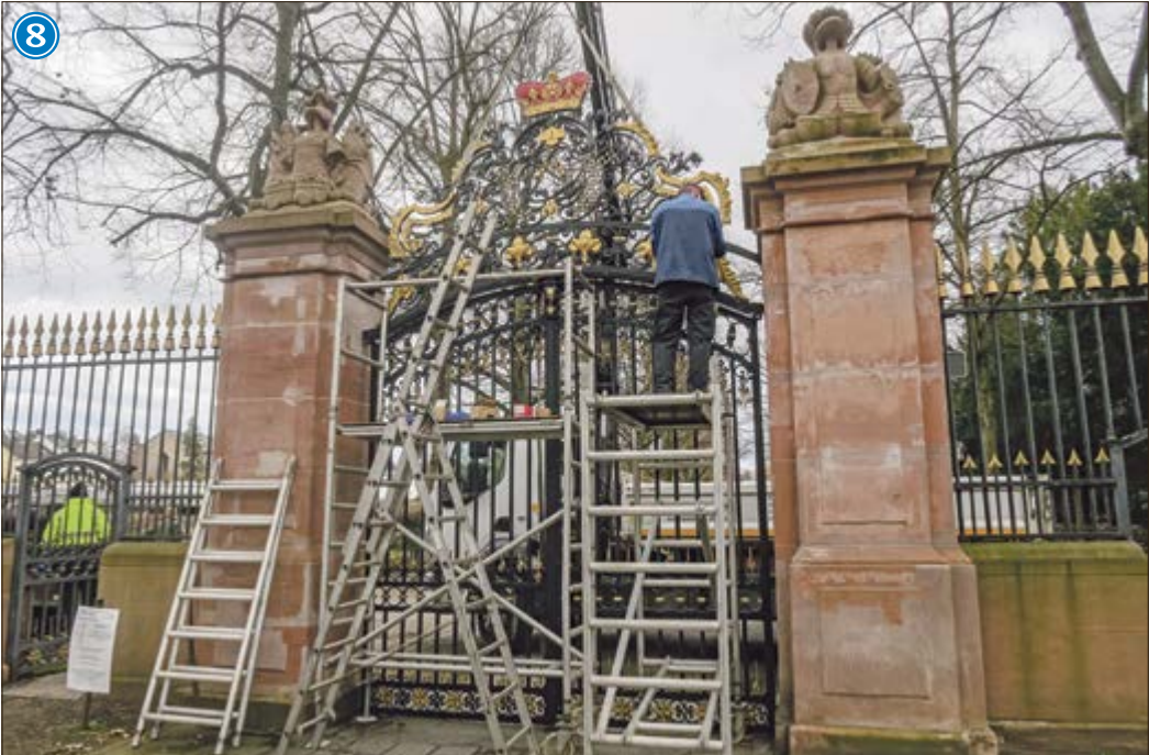
... konnte der fachgerechte Einbau des über 800 Kilogramm wiegenden schmiedeeisernen Tores am 7. März 2019 vonstatten gehen. (Bilder: Ralf Hellriegel, Wolfgang Martin)
