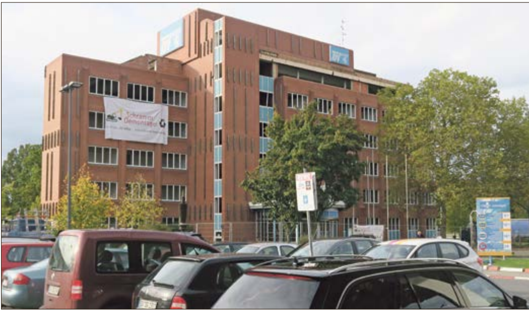
DER ABRISSEBIRNE ZUM OPFER FÄLLT DIESER TAGE DAS EHEMALIGE TÜV-VERWALTUNGSGEBÄUDE AUF DEM AREAL DES „MARKTPLATZ BESSUNGEN“. Bereits Anfang nächsten Jahres sollen hier Wohnungen entstehen. (Bild: Ralf Hellriegel)
