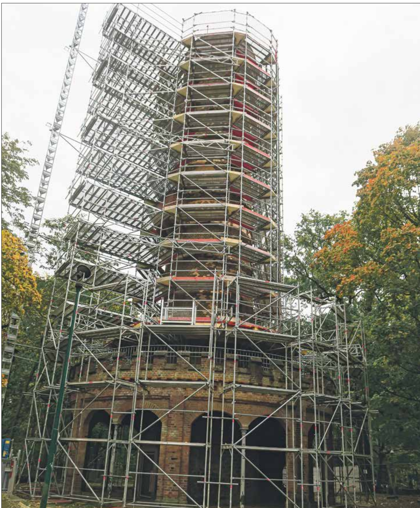
IMPOSANT. Der eingerüstete Ludwigsturm. (Zum Bericht)
