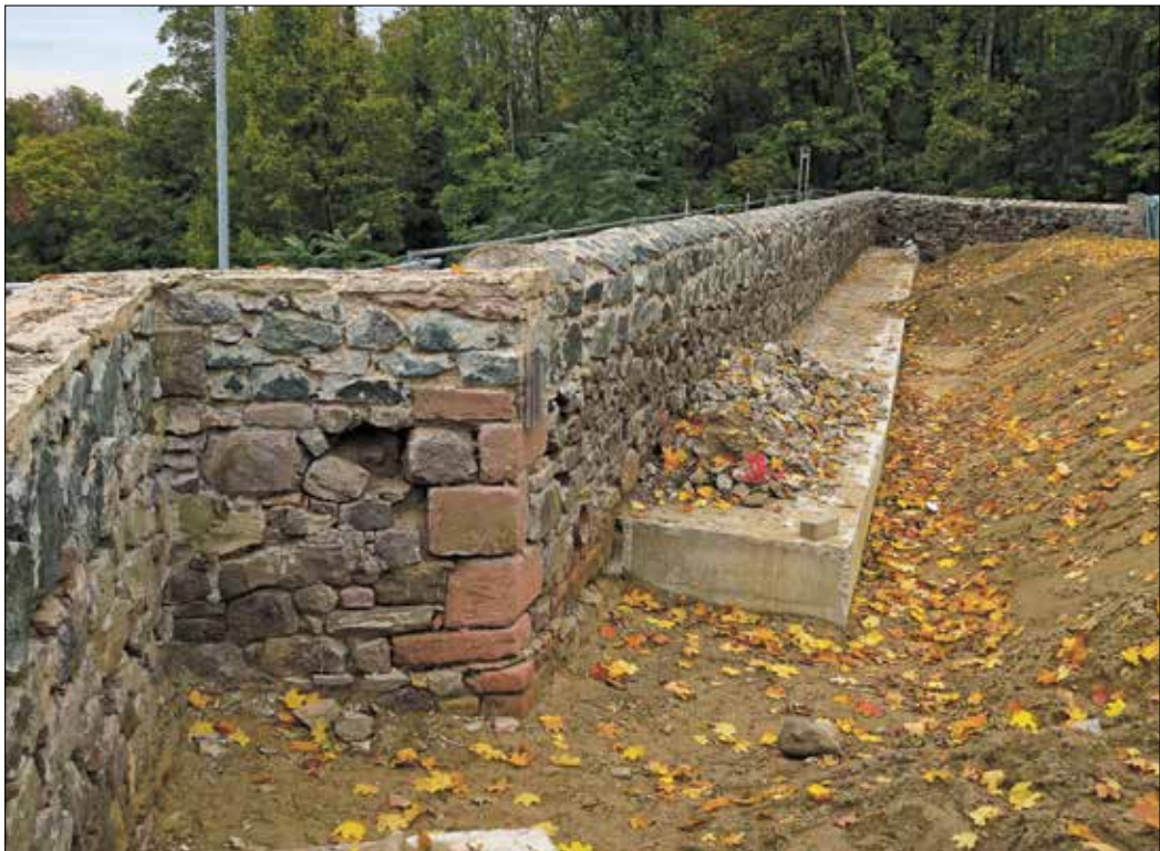
STATISCHE ERTÜCHTIGUNGEN mittels Betonstabilisierungen an der Bruchsteinmauer im Terrassenbereich. (Bild: Ralf Hellriegel)
